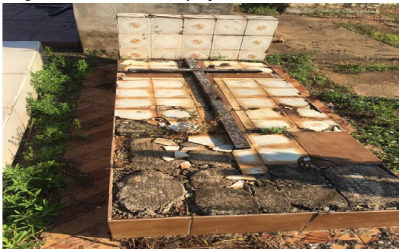
Imagem n.8 – Túmulo em situação precária.
